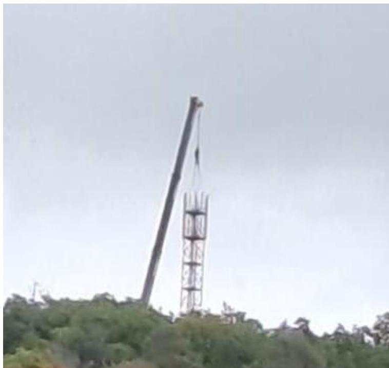
Der vor Ort montierte Mast wird am 27.09.22 mit Hilfe eines Autokranes aufgestellt
